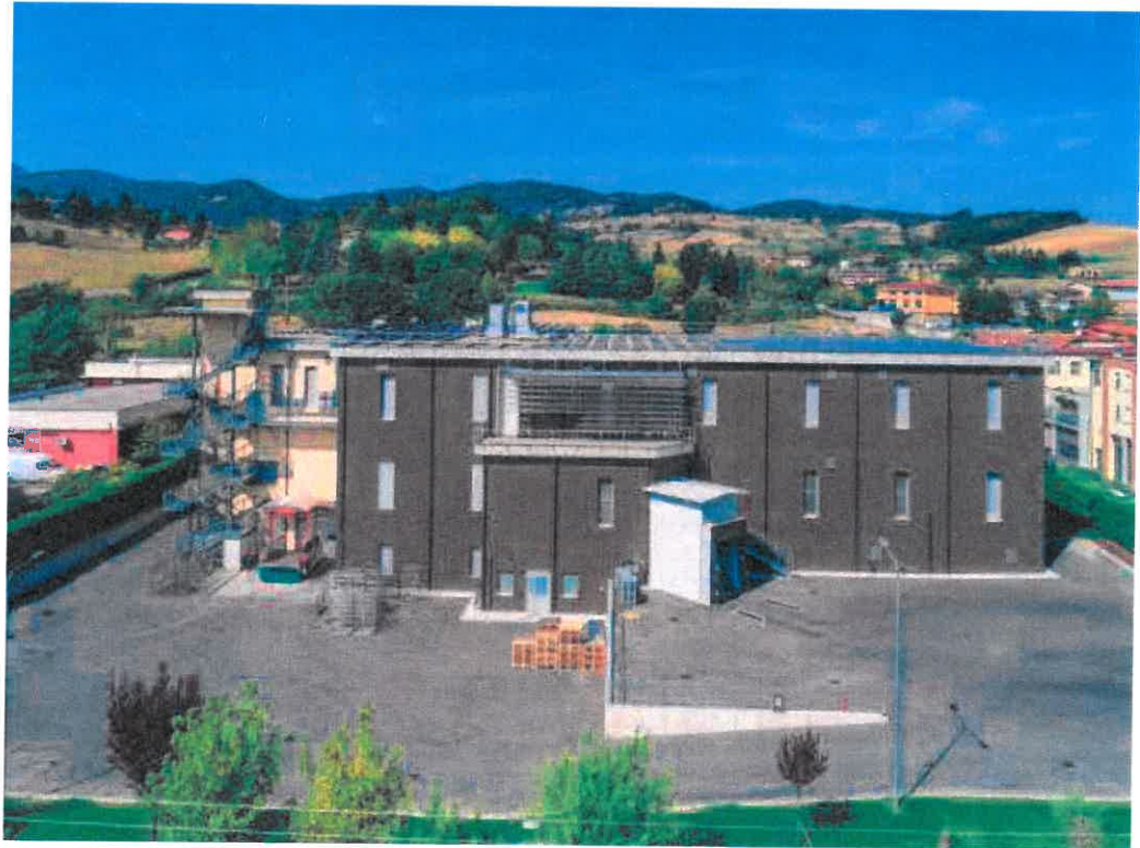
Stabilimento MP 2 di Strada Mulino Fabiola, 13 a Langhirano (PR)
